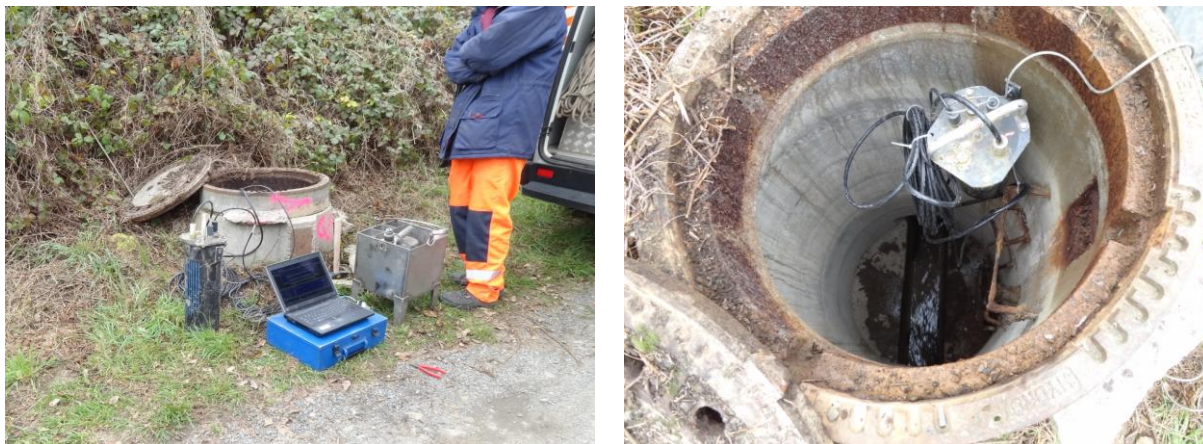
Obr. 2: Osazování měřící techniky v profilu MP5.
