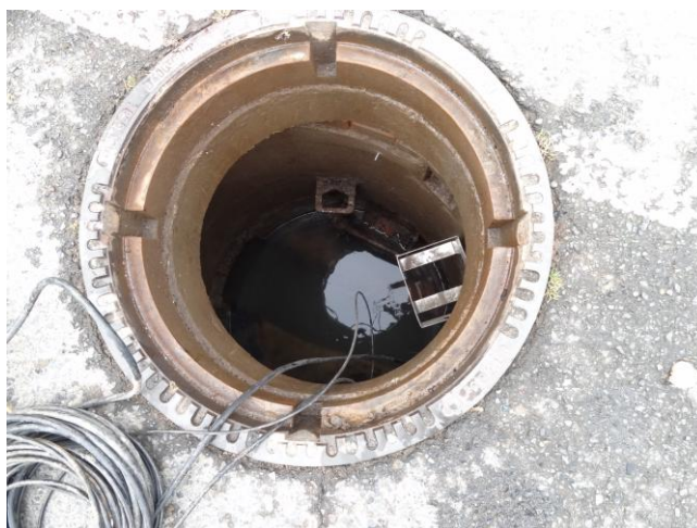
Obr. 3: Vzduťatá hladina v šachtě při osazování měrného profilu MP4.
