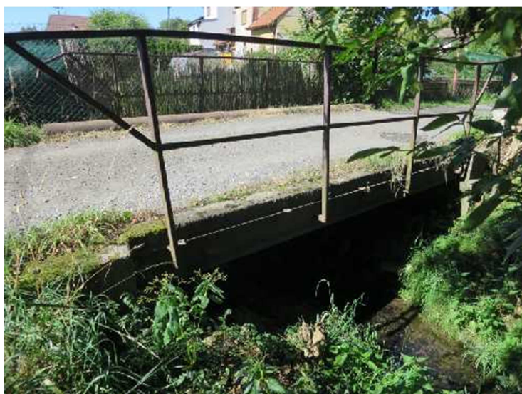
pohled na most
