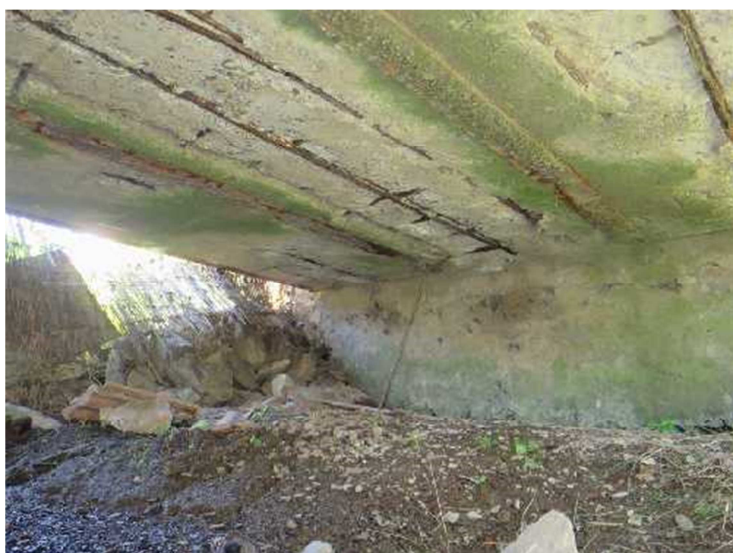
podhled nosné konstrukce
