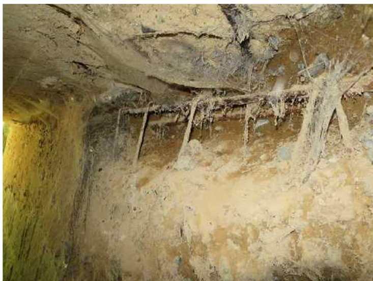
hloubková degradace betonu koncového příčnicku
