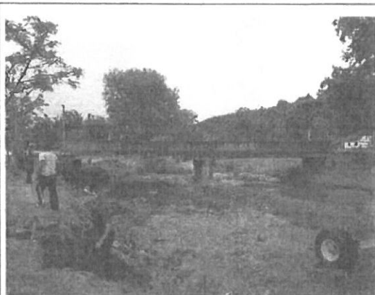
Přípravné práce pro nové schodiště
