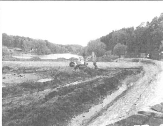
Zemní práce pod přelivnou hranou jezu
