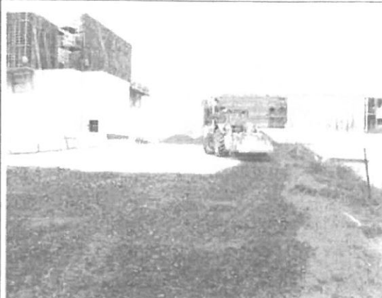
Podkladní vrstvy pod komunikace
