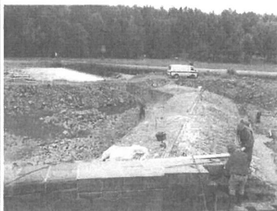
Oprava vorové vpusti a přelivné hrany jezu
