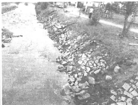
Pohled na stávající dlažby – opevnění břehu
