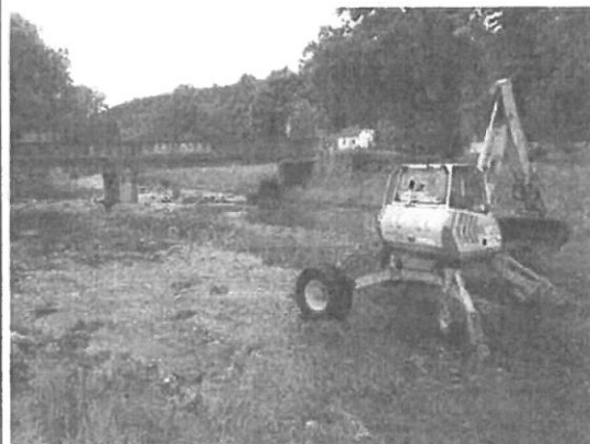
Práce v toku řeky, úprava podloží
