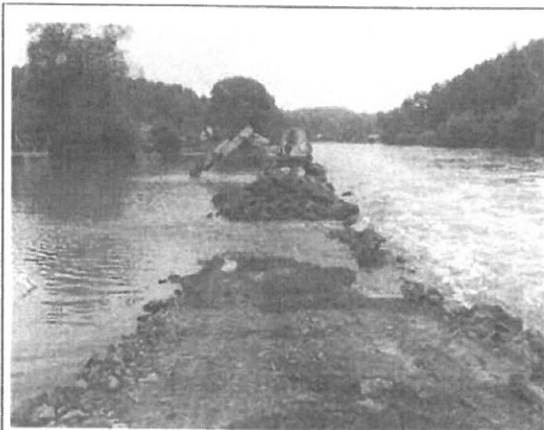
Práce na přehrazení toku řeky
