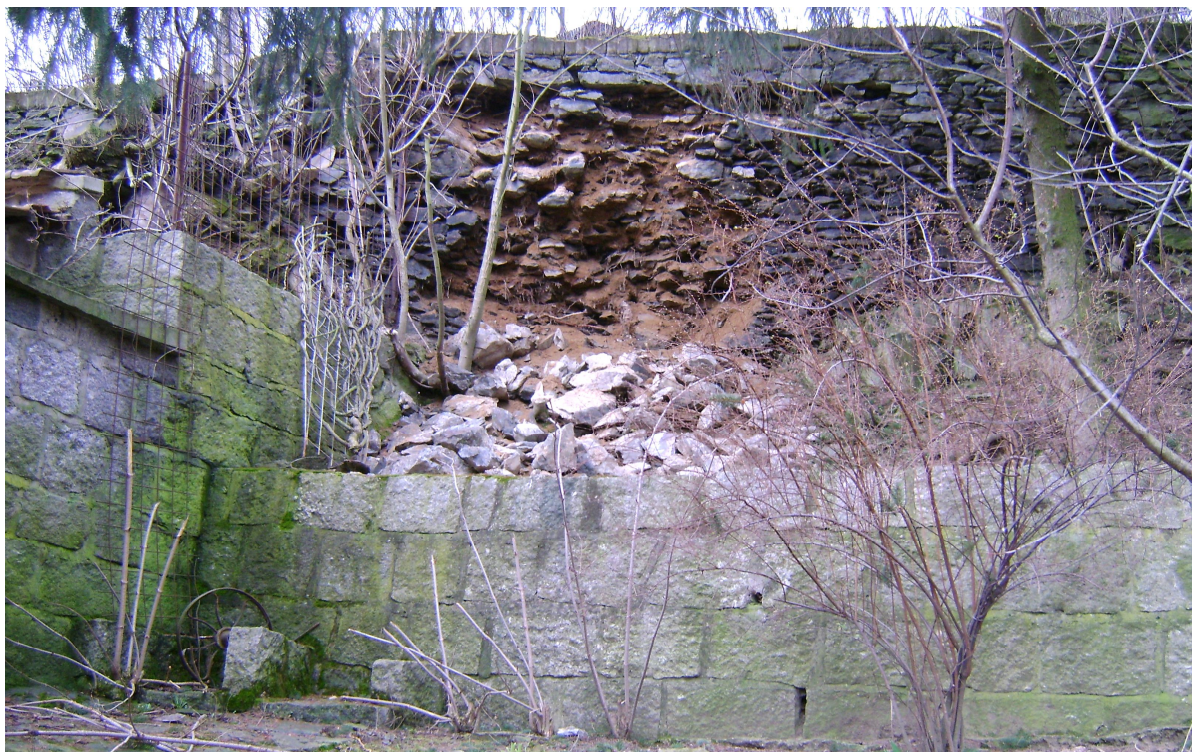
Pohled na sespanou část opěrné stěny
