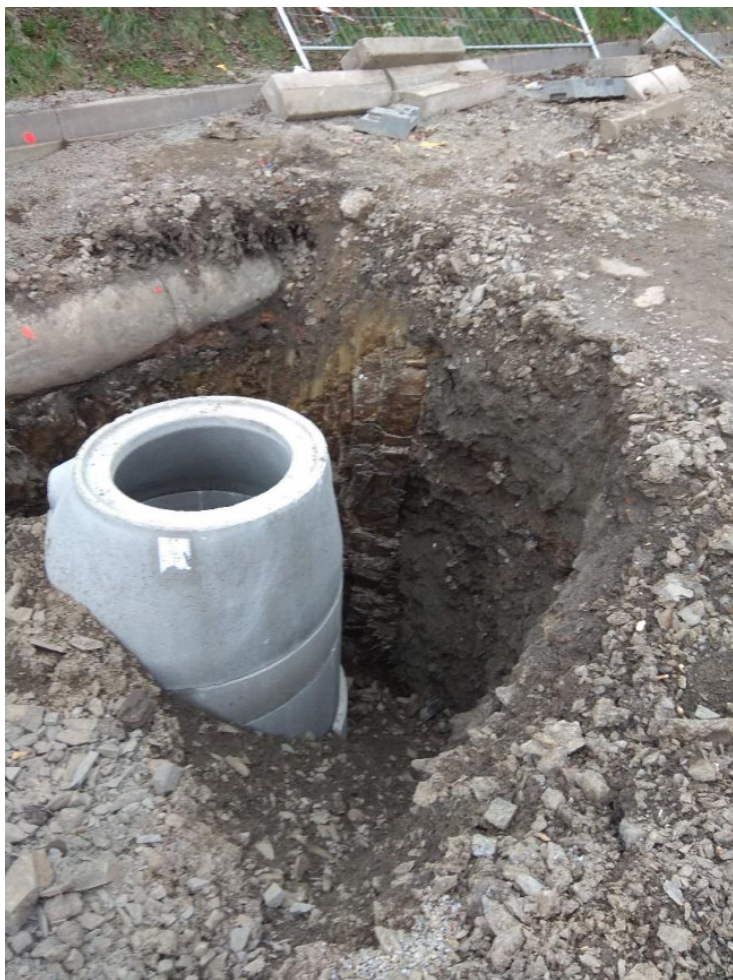
Výkop v místě šachty 1.07
