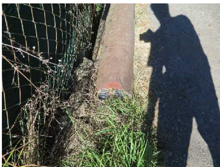
kabelové sítě jsou převáděny v chrániče v úrovni vozovky
