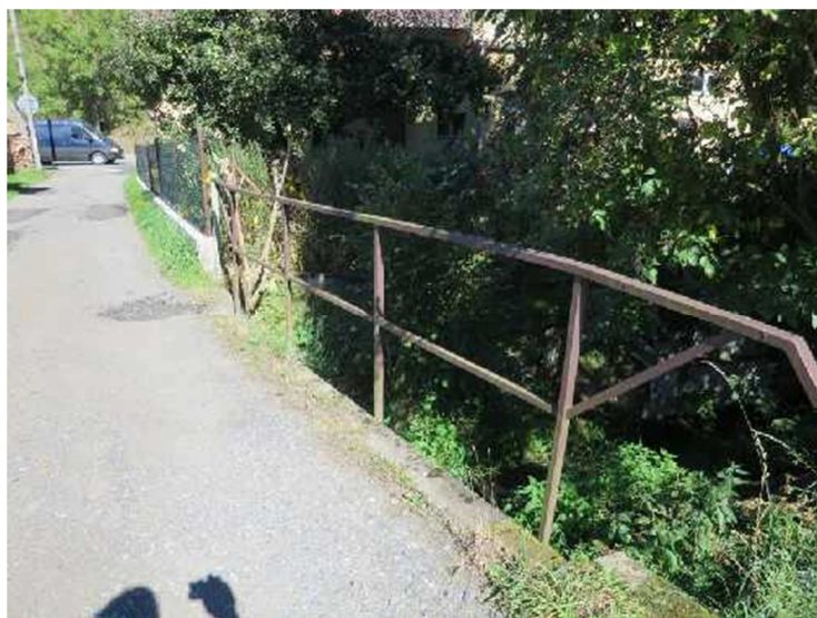
omezeně funkční záchytný systém
