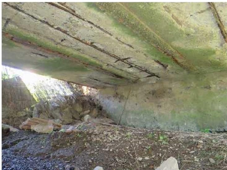
podhled nosné konstrukce
