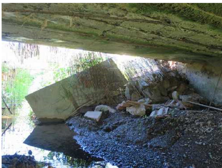
pletivo na začátku mostního otvoru
