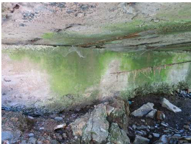
pohled na pravobřežní opěru 2
