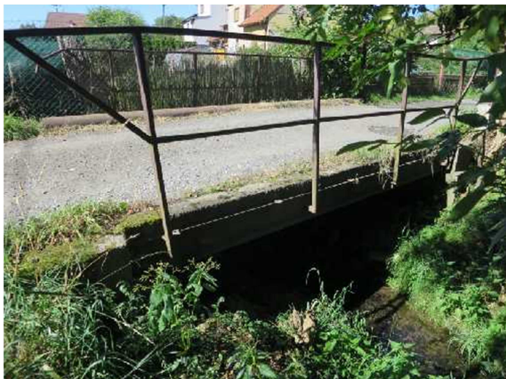
pohled na most
