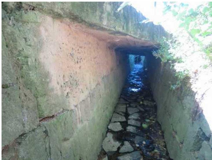
pohled na propustek
