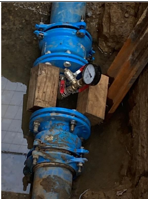
Foto /27/ Místo řešené poruchy V2: Zásah do vodovodu v ul. Psárská u č.p. 10 (snímek rozpojeného vodovodu byl pořízen 15. 10. 2021).
