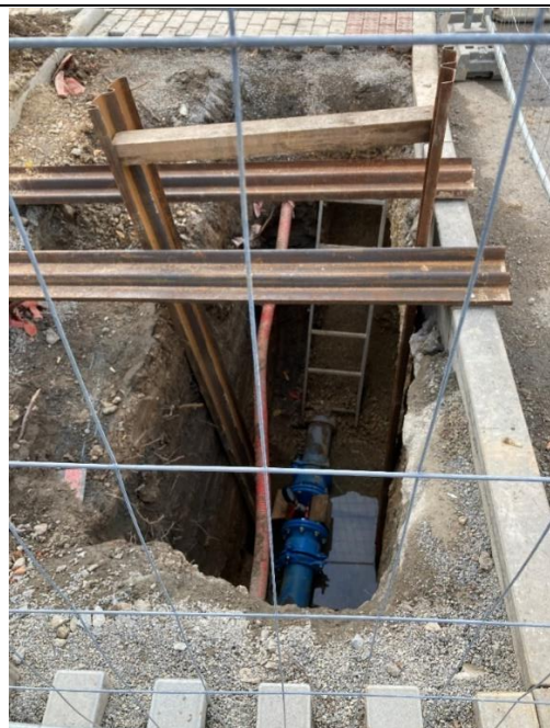
Foto /28/ Místo řešené poruchy V2: Zásah do vodovodu v ul. Psárská u č.p. 10 (snímek pořízen 15. 10. 2021).
