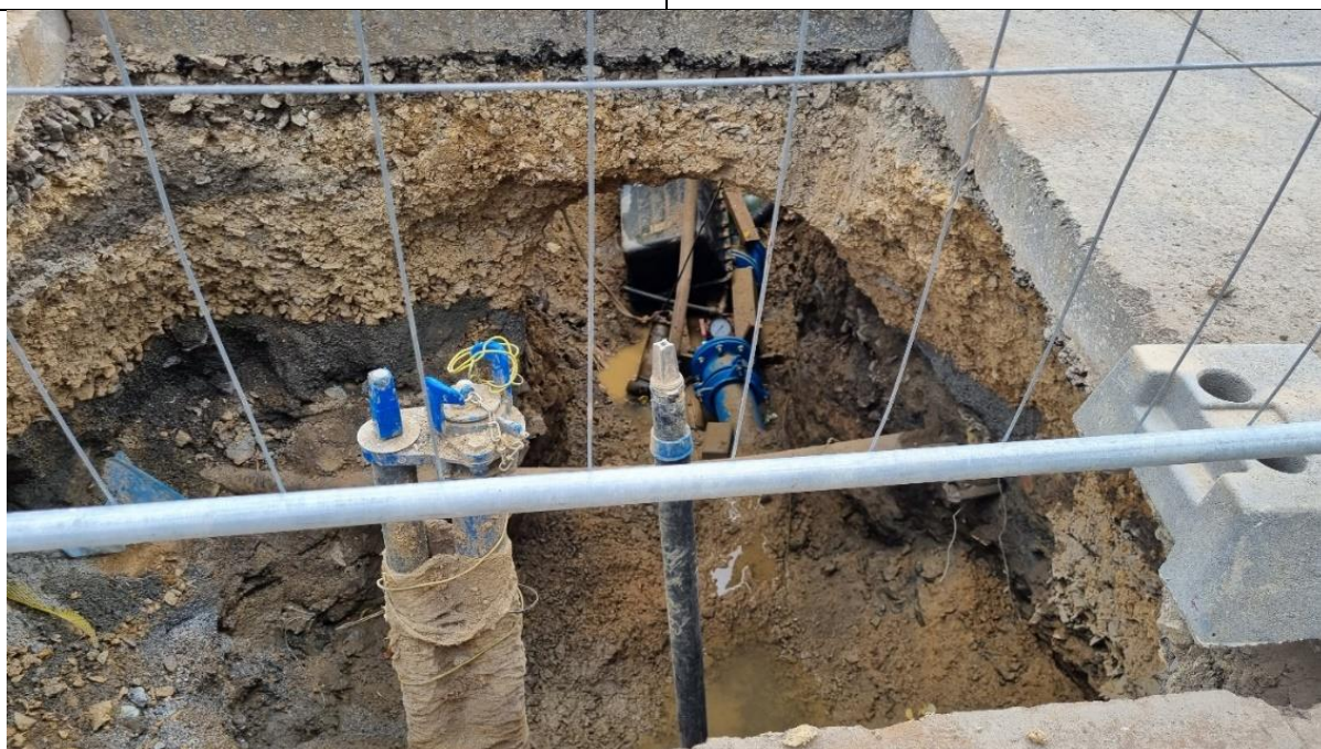
Foto /15/ Místo řešené poruchy V4: Zásah do vodovodu v ul. Pod Vápenkou (snímek z 17. 8. 2021).
