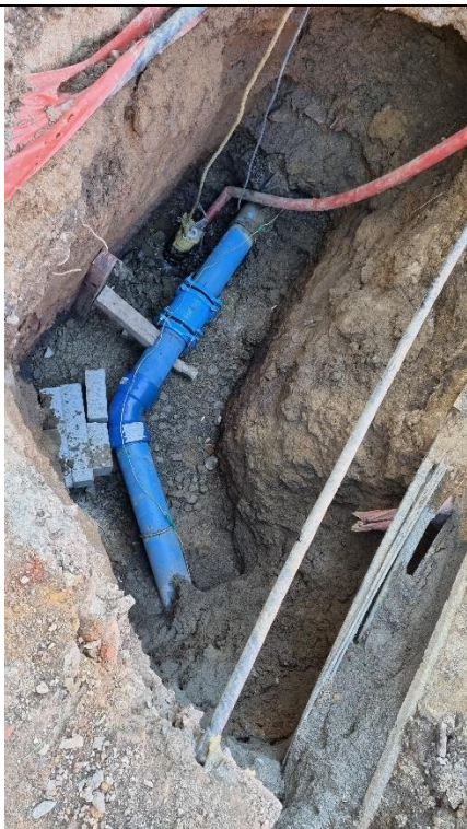
Foto /35/ Místo řešené opravy V3: Zásah do vodovodu v ul. Psárská u č.p. 8 (snímek pořízen 18. 10. 2021).
