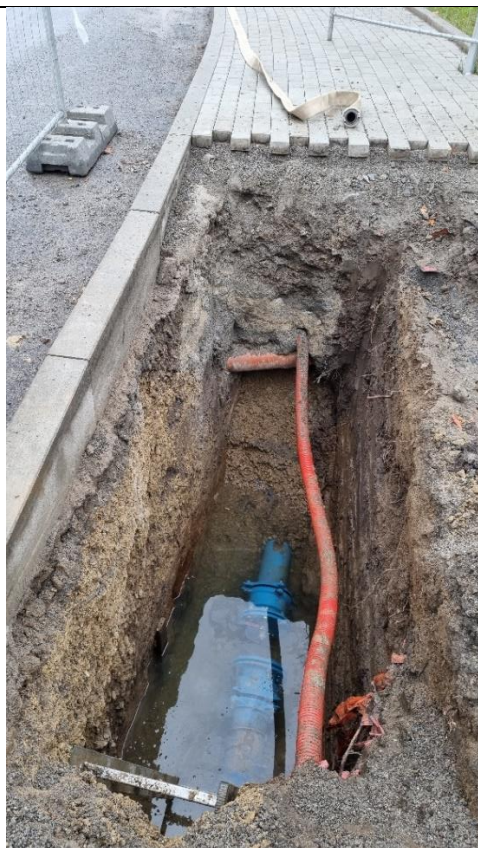
Foto /26/ Místo řešené poruchy V2: Zásah do vodovodu v ul. Psárská u č.p. 10 (snímek pořízen 14. 10. 2021). Porucha V2 je spolu s dalšími zásahy zakreslena v příloze č. 2.
