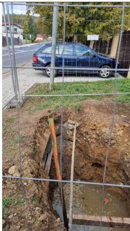
Foto /12/ Místo řešené poruchy V3 : Zásah do vodovodu v ul. Psárská u č.p. 8 (snímek pořízen 16. 8. 2021).
