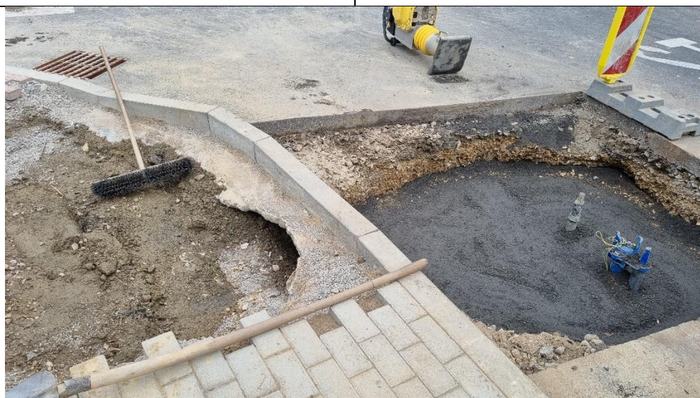
Foto /18/ Místo řešené poruchy V4: Zásah do vodovodu v ul. Pod Vápenkou (snímek pořízen 20. 8. 2021).
