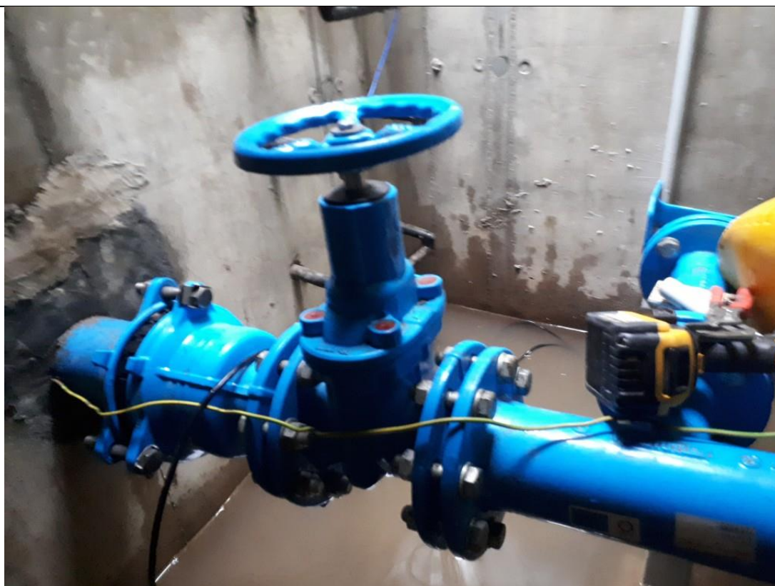
Foto /46/ Detail Š DN100 směrem k OÚ Psáry (snímek pořízen 25. 1. 2022).
