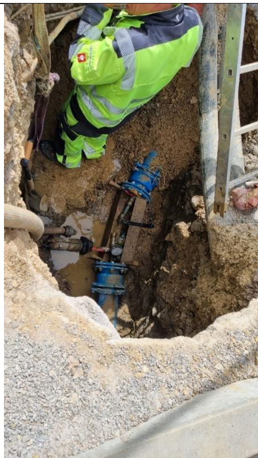
Foto /14/ Místo řešené poruchy V4: Zásah do vodovodu v ul. Pod Vápenkou (snímek pořízen 18. 8. 2021). Na snímku je patrné rozmontované potrubí.
