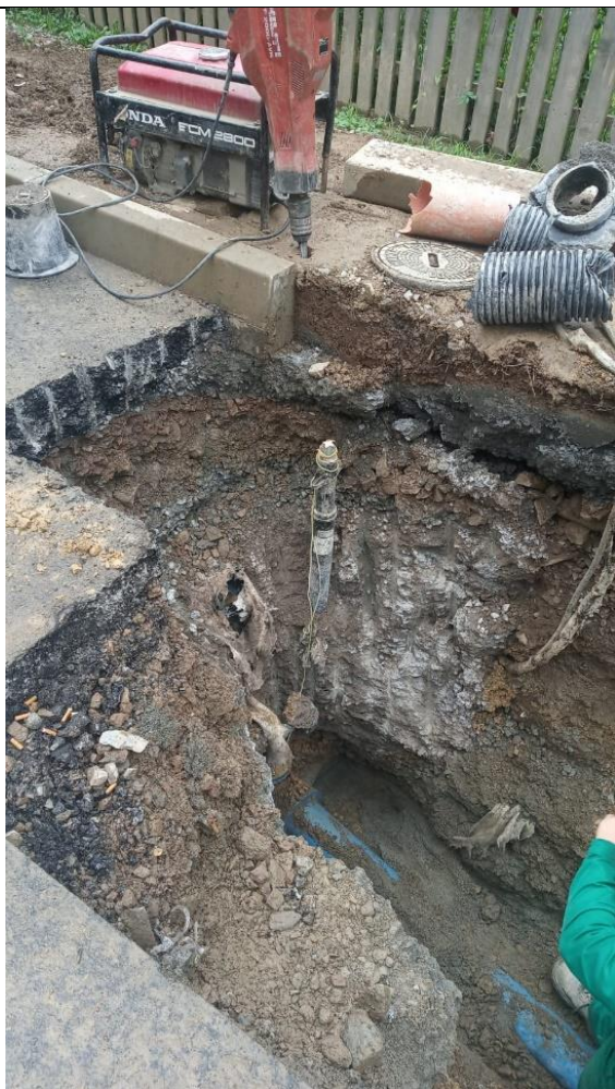
Foto /6/ Místo řešené poruchy V8: Zásah do vodovodu před budovou OÚ Psáry (snímek pořízen 5. 8. 2021).
