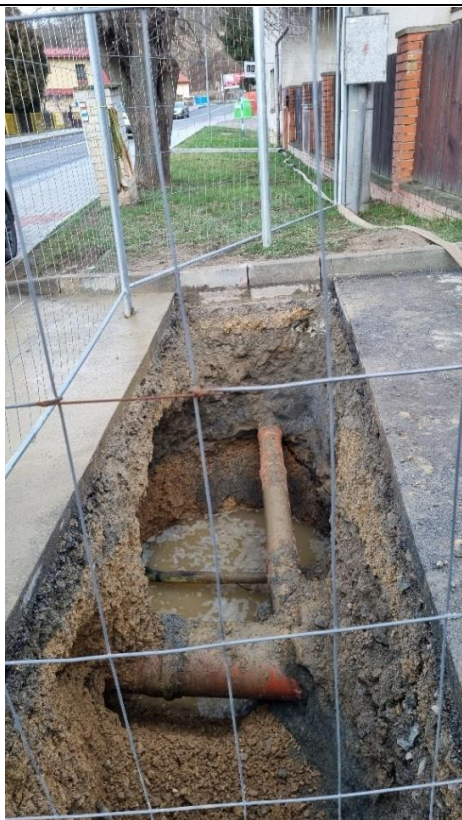
Foto /40/ Místo řešené opravy V5: Zásah do vodovodu v ul. Pod Vápenkou (snímek pořízen 5. 1. 2022).
