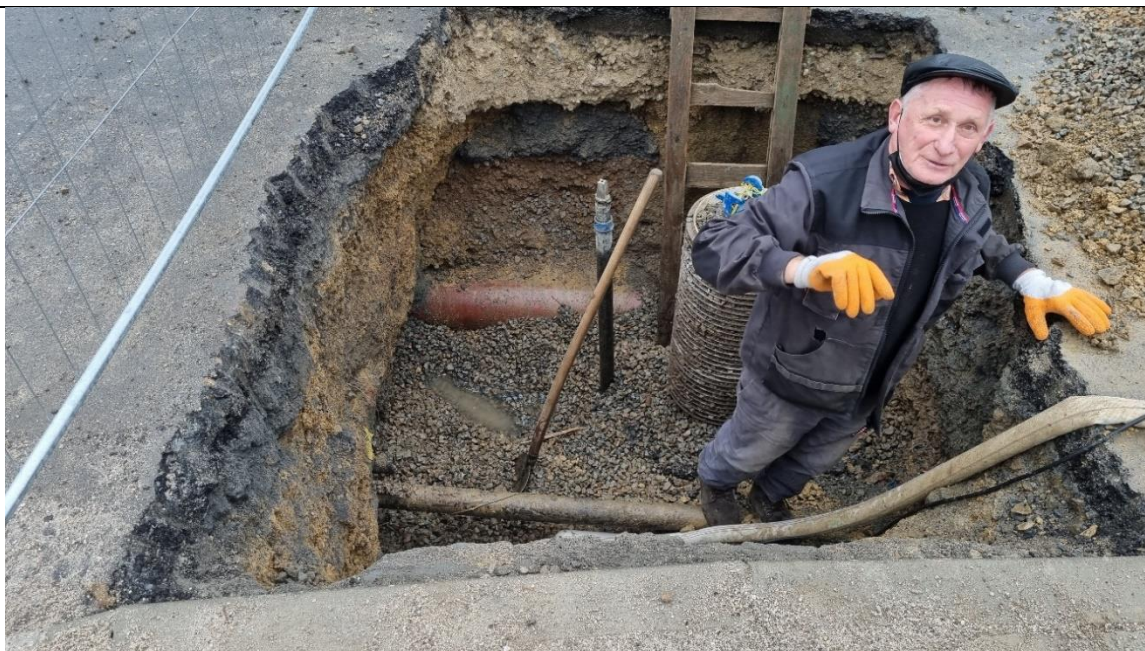
Foto /38/ Místo řešené přeložky vodovodu V4: Zásah v ul. Pod Vápenkou (snímek pořízen 16. 12. 2021).
