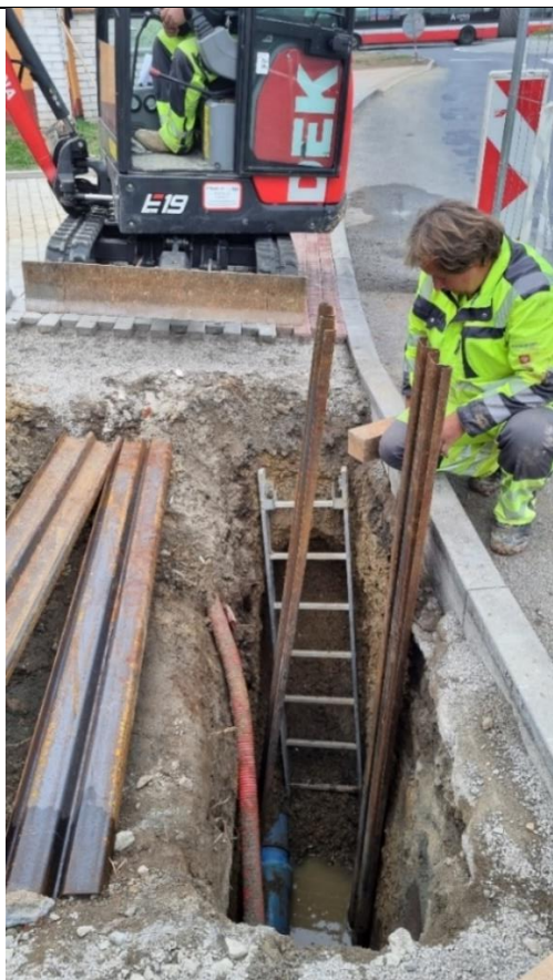
Foto /19/ Místo řešené poruchy V2: Zásah do vodovodu u domu č.p. 10 v ul. Psárská (snímek pořízen 4. 10. 2021).
