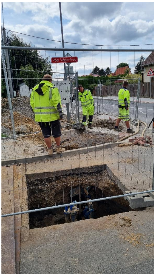
Foto /16/ Místo řešené poruchy V4: Zásah do vodovodu v ul. Pod Vápenkou (snímek pořízen 17. 8. 2021).
