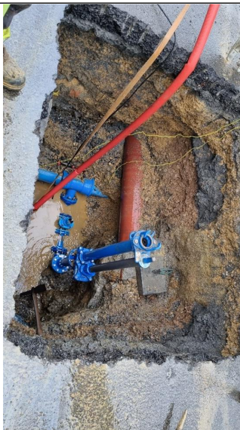
Foto /22/ Místo řešené poruchy V4: Zásah do vodovodu v ul. Pod Vápenkou (snímek pořízen 14. 10. 2021).
