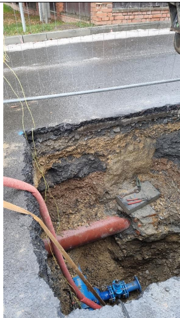
Foto /23/ Místo řešené poruchy V4: Zásah do vodovodu v ul. Pod Vápenkou (snímek pořízen 14. 10. 2021. Z potrubí byl demontován hydrant.
