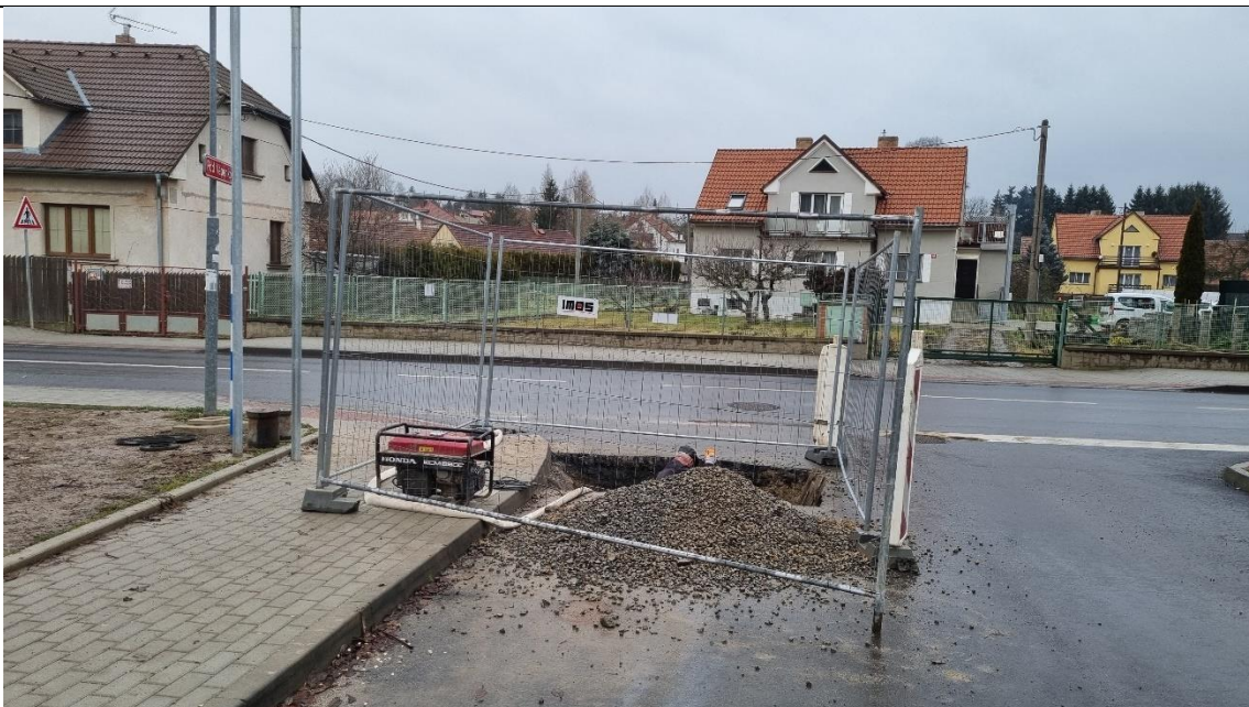
Foto /37/ Místo řešené přeložky vodovodu V4: Zásah v ul. Pod Vápenkou (snímek pořízen 16. 12. 2021), neexistuje stavební deník. Místo výkopu je shodné s místem provádění předchozích zásahů do vodovodu v ul. Pod Vápenkou.
