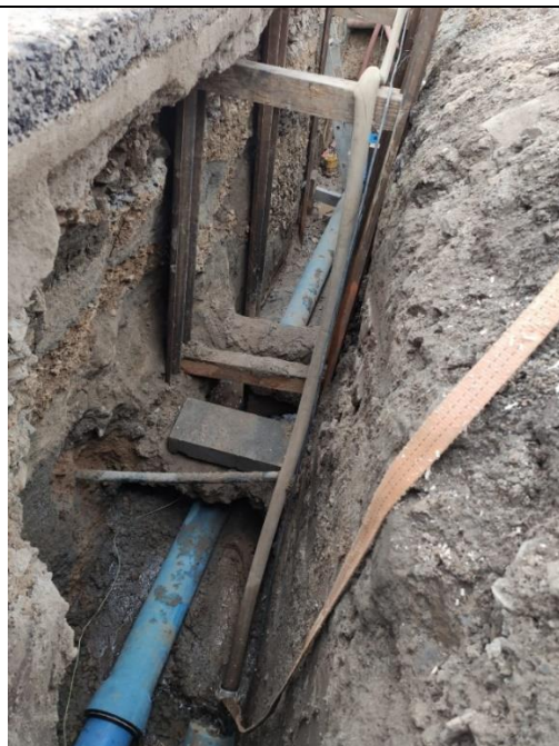
Foto /32/ Místo řešené opravy V2: Zásah do vodovodu v ul. Psárská u č.p. 10 (snímek pořízen 25. 10. 2021).
