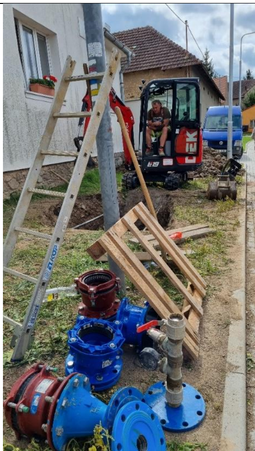
Foto /13/ Místo řešené poruchy V3: Zásah do vodovodu v ul. Psárská u č.p. 8 (snímek pořízen 17. 8. 2021).
