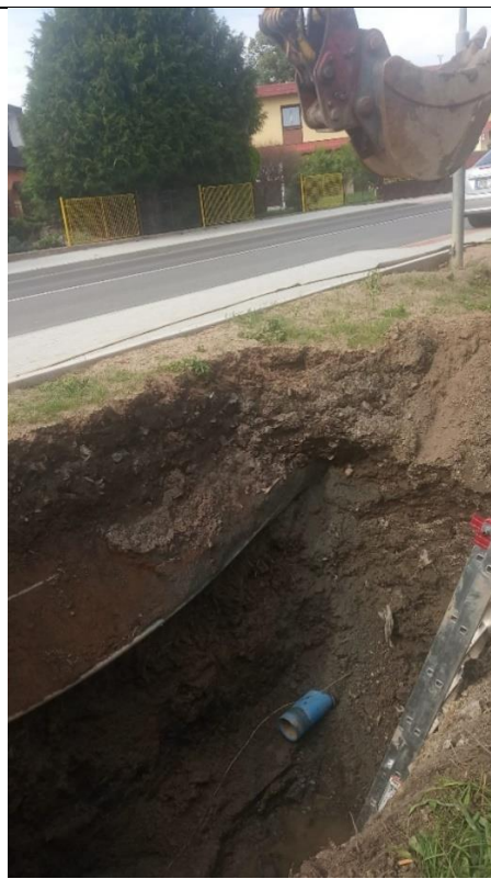
Foto /9/ Místo řešené poruchy V6: Zásah do vodovodu v ul. Psárská u č.p. 5 (snímek pořízen 10. 8. 2021). Na snímku je vidět rozmontované potrubí.
