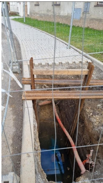
Foto /11/ Místo řešené poruchy V2 : Zásah do vodovodu v ul. Psárská u č.p. 10 (snímek pořízen 16. 8. 2021).
