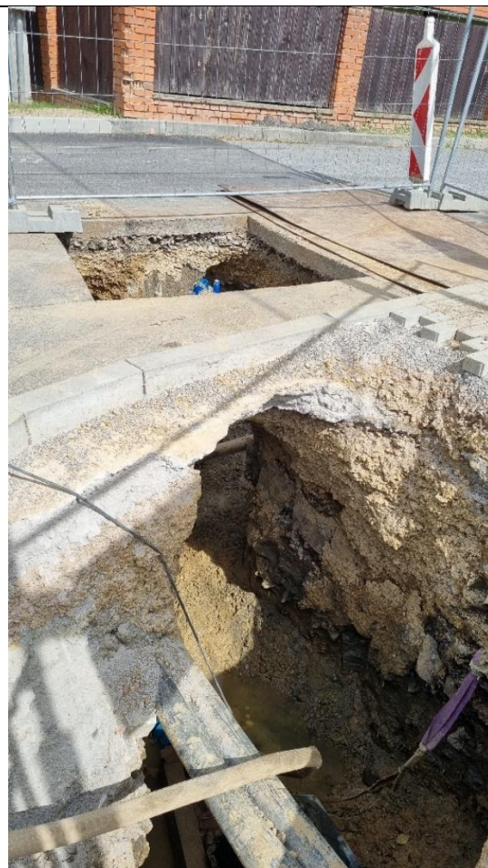
Foto /17/ Místo řešené poruchy V4: Zásah do vodovodu v ul. Pod Vápenkou (snímek pořízen 17. 8. 2021).
