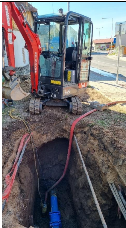
Foto /36/ Místo řešené opravy V3: Zásah do vodovodu v ul. Psárská u č.p. 8 (snímek pořízen 18. 10. 2021).
