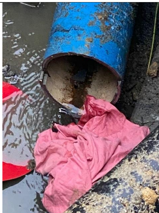
Foto /44/ Místo řešené opravy V5: Zásah do vodovodu v ul. Pod Vápenkou (snímek pořízen 10. 1. 2022).
