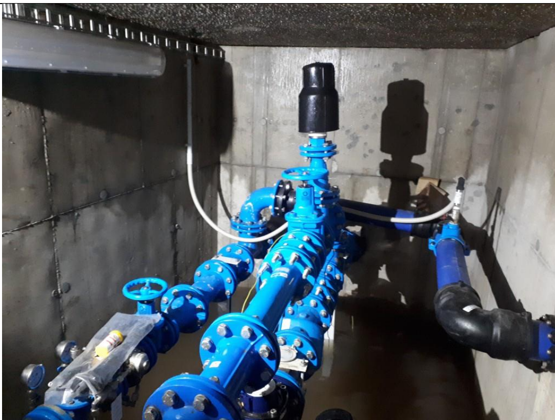
Foto /45/ Celkový pohled do vodoměrné a redukční šachty včetně vzdušníku a prostupu odbočky z PE d110 (snímek pořízen 25. 1. 2022).
