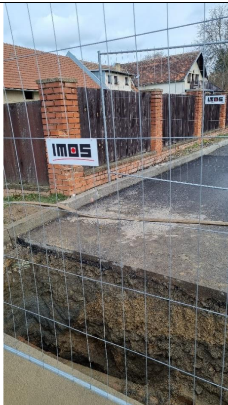
Foto /41/ Místo řešené opravy V5: Zásah do vodovodu v ul. Pod Vápenkou (snímek pořízen 5. 1. 2022).
