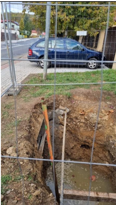
Foto /33/ Místo řešené opravy V3: Zásah do vodovodu v ul. Psárská u č.p. 8 (snímek pořízen 16. 10. 2021).
