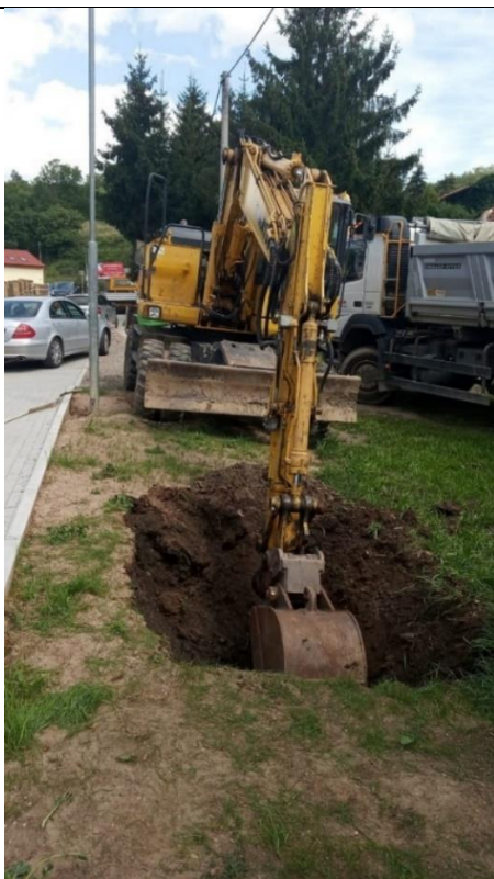
Foto /8/ Místo řešené poruchy V6: Zásah do vodovodu v ul. Psárská u č.p. 5 (snímek pořízen 10. 8. 2021).
