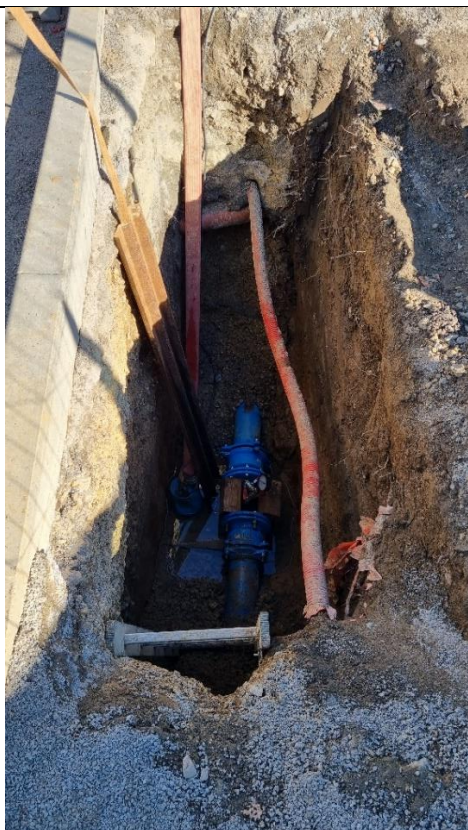
Foto /29/ Místo řešené poruchy V2: Zásah do vodovodu v ul. Psárská u č.p. 10 (snímek pořízen 18. 10. 2021).
