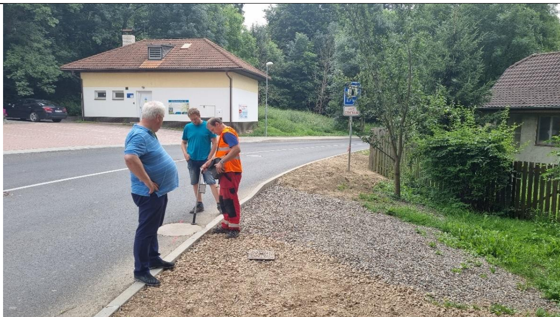
Foto /3/ Hledání úniků vody (snímek pořízen 28. 7. 2021).
