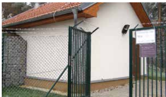
Vodojem Vysoká 2 x 150 m 3
